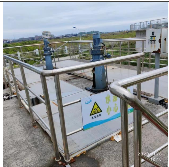
废气加盖处理
